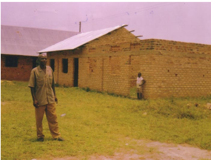
Dieses Foto stammt aus Kihühi, wo unser erster Baueinsatz im Januar und Februar 2000 stattfand. Damals wurde in dieser ugandischen Kleinstadt eine Grundschule mit fünf Klassenräumen und einem Bürobereich gebaut. Jetzt wurden in Eigeninitiative zwei Klassenräume hinzugefügt. Die Schulleitung hat uns vor wenigen Wochen mitgeteilt, dass noch Hilfe bei der Finanzierung der Wellblechdächer für ein Gebäude und für die Elektrifizierung der Schule benötigt wird.
