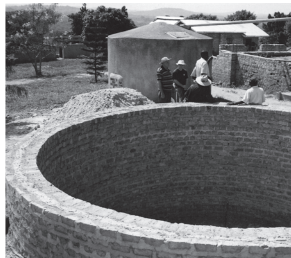
Das Regenwasserauffangbecken am Hillside College in Bau
